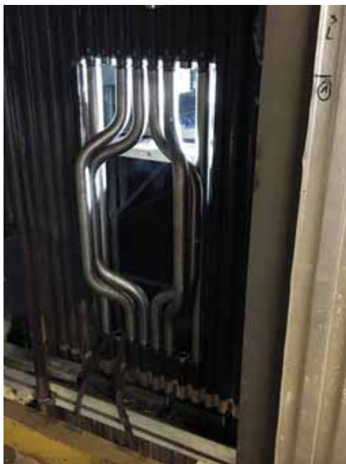
Rohrausbiegungen für eine neue Einstiegstüre der OL 3
