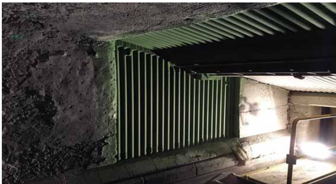
Die Ausbrandzone der Ofenlinie 3 wird neu beschichtet.
