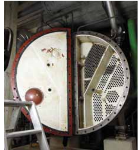
Kondensator der Turbogruppe 1
