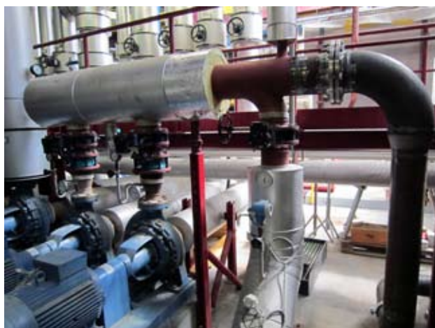
Neue Verbindungsleitung vom Turgi-Ast zum Siggenthaler-Ast
