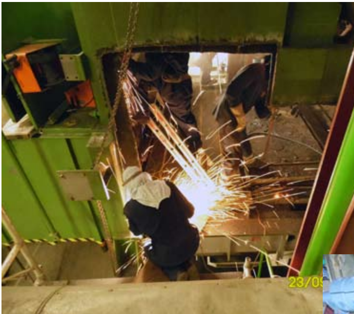
Montage der neuen Müllschacht-Seitenwand
