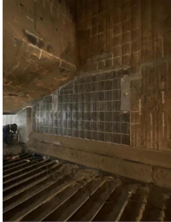
Das Seitenwandmauerwerk der Ofenlinie 4 musste deshalb neu aufgebaut werden.
