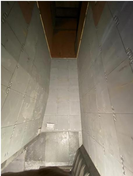
Der Müllschacht der Ofenlinie 4 musste komplett ersetzt werden.
