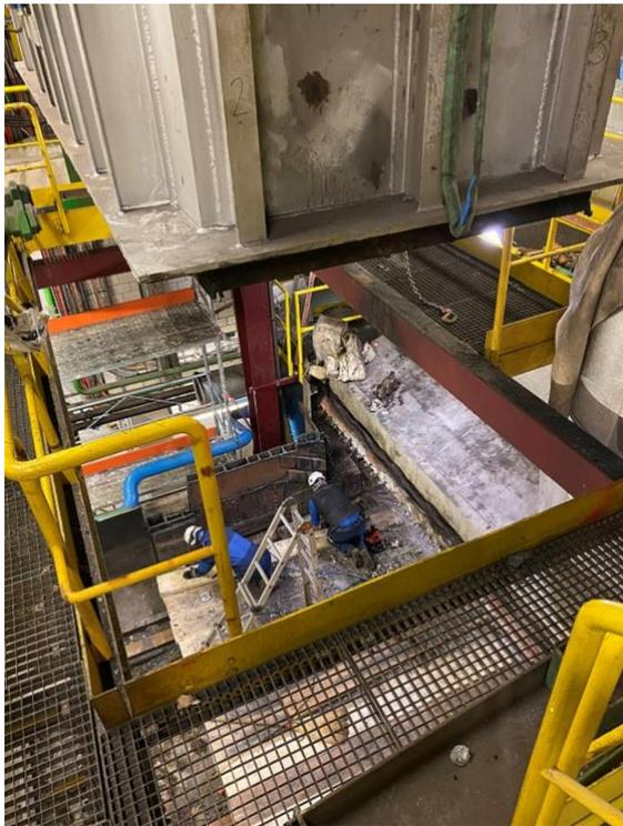
Das Projekt Ersatz Müllschacht – hier nach der Demontage und vor dem Einbau des neuen Schachts – konnte unfallfrei abgeschlossen werden.
